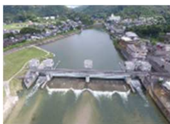
耐震補強工事を待つ川上頭首工
