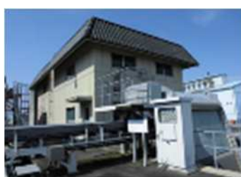
久保田第2排水機場(平成13年造成)
