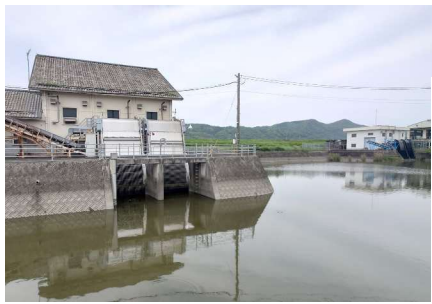
友田排水機場： 国営（写真左）及び市営 （写真右）の排水機場を 廃止、新たに機能強化し た排水機場を整備
