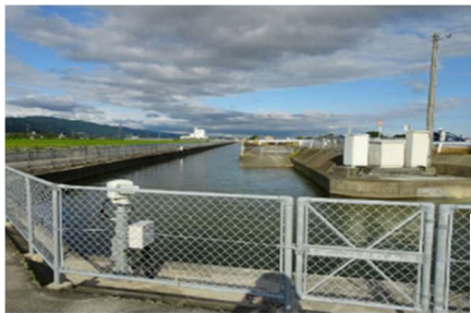
右岸幹線水路：各施設・ 設備の整備・更新
