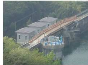
取水設備の更新
