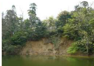
貯水池法面の崩落状況
