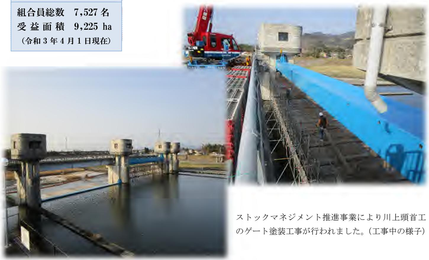
ストックマネジメント推進事業により川上頭首工のゲート塗装工事が行われました。(工事中の様子)
